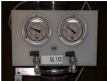
Mynd 2: Mælplata síu með sýnitöku krönnum. Sandsía í rekstrarstöðu
